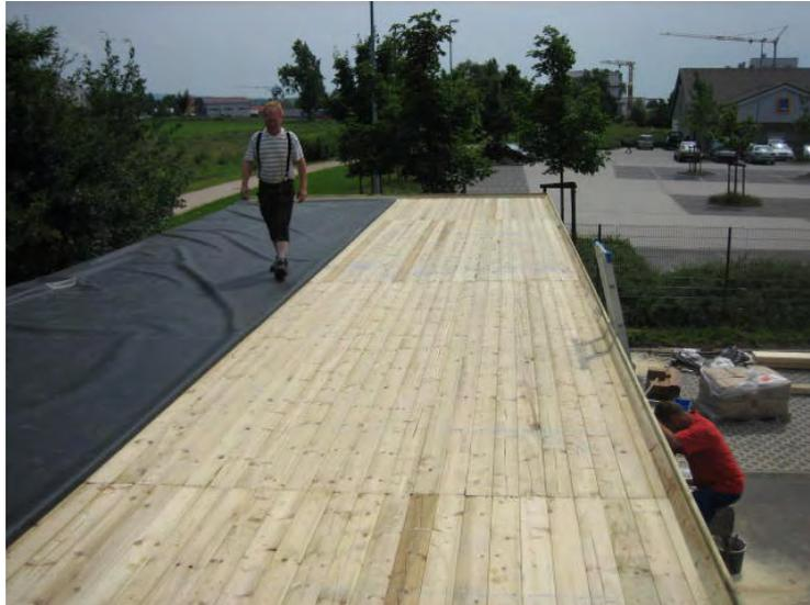
Bild 4. EPDM-Plane zur Hälfte zurückgeschlagen.
