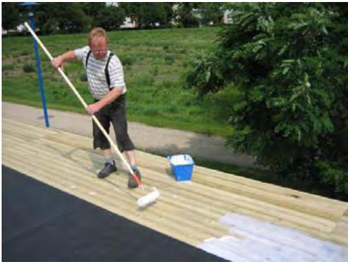
Bild 5. Klebmasse aufrollern.
