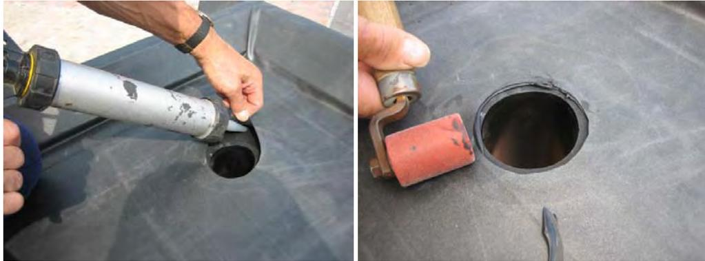
Bild 23. und 24. Abdichtung Plane – Ablaufflansch.
