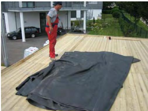
Bild 2. Ausrollen der EPDM-Plane.
