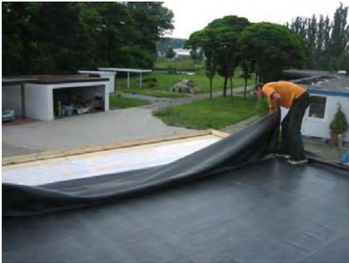
Bild 7. Plane in den Kleber schieben.
