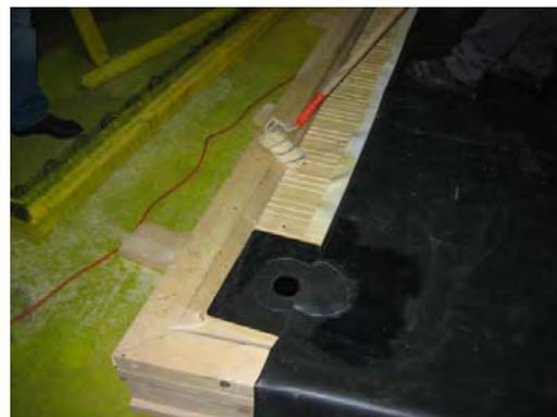
Bild 20. Flansch und Plane einkleben.
