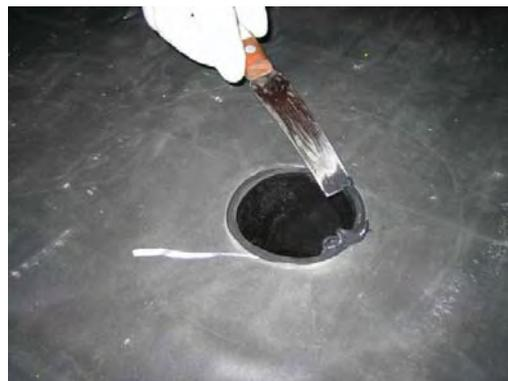
Bild 25. Ausstretende Dichtmasse entfernen.
