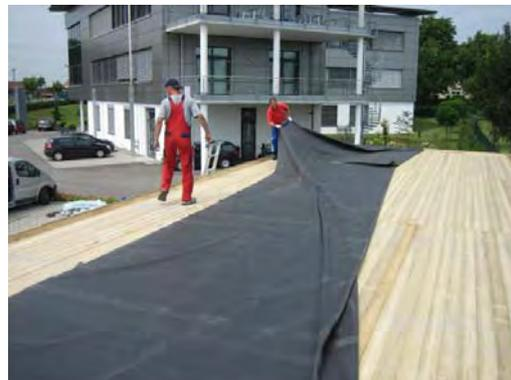
Bild 3. Plane 0,5 Stunden ruhen lassen.
