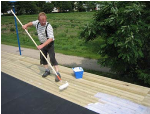
Bild 5. Klebmasse aufrollern.
