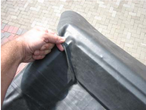
Bild 13. Einfalten der Innenecken.
