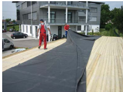
Bild 3. Plane 0,5 Stunden ruhen lassen.
