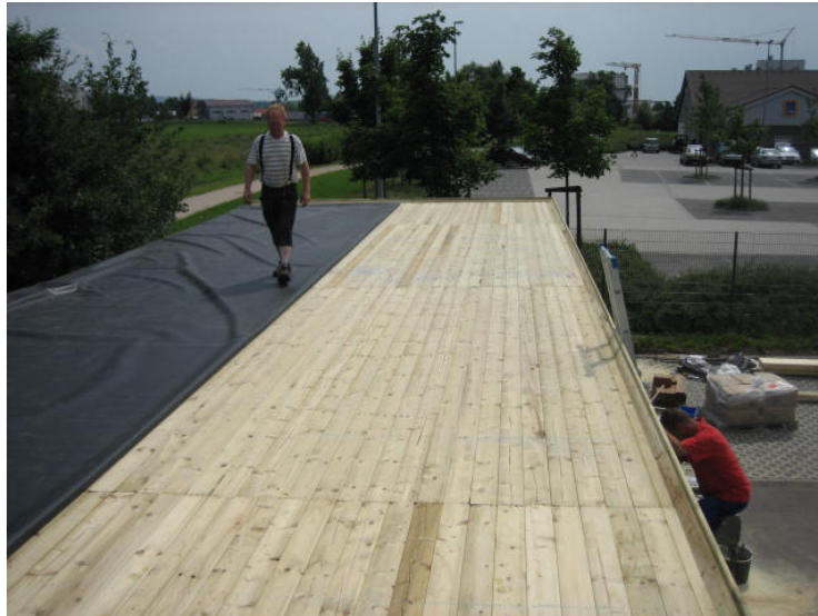
Bild 4. EPDM-Plane zur Hälfte zurückgeschlagen.
