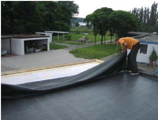
Bild 7. Plane in den Kleber schieben.
