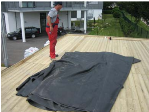
Bild 2. Ausrollen der EPDM-Plane.
