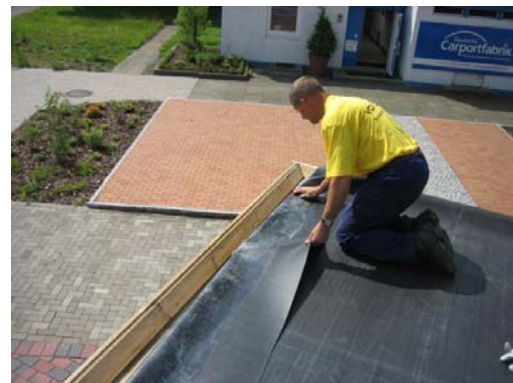
Bild 10. Plane in die Attika drücken.
